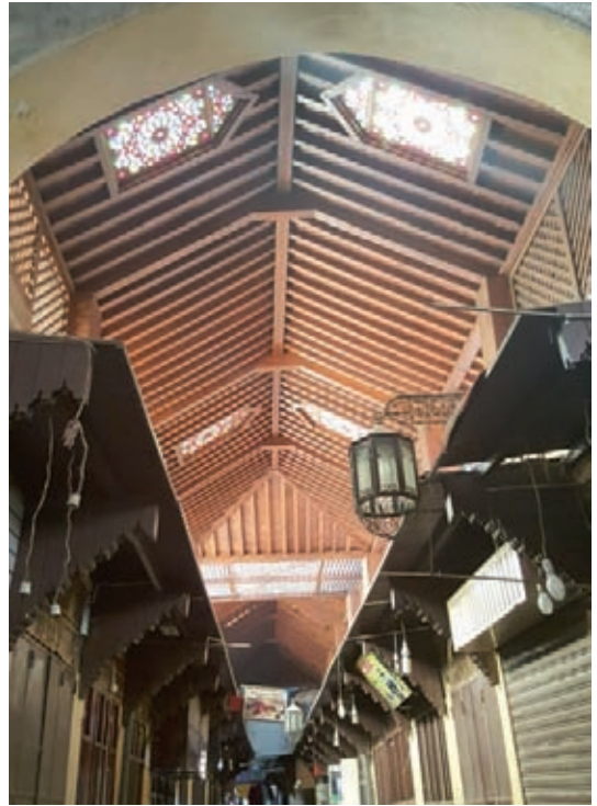
Couverture en toiture «Berchla» (Médina de Meknès)
