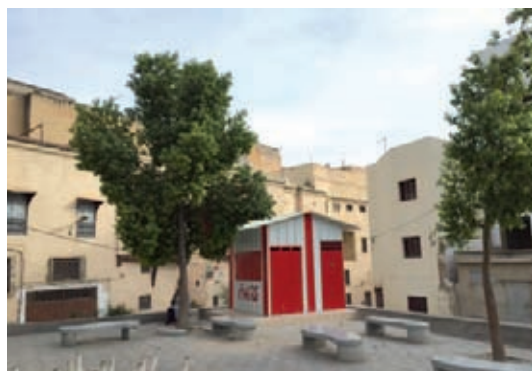
Couverture en toiture «Berchla» (Médina de Meknès)
