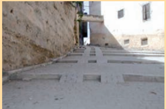
Réadaptation de la rue pour accueillir du trafic
