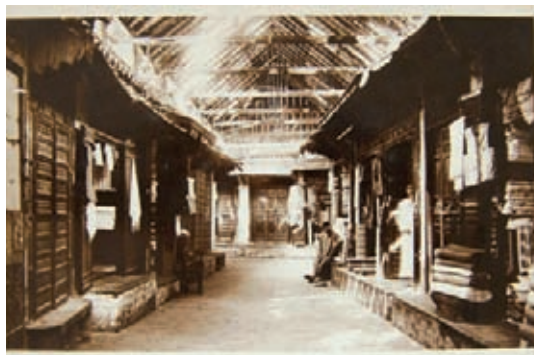
Couverture en toiture de type «Berchla» - Souk des soieries à Meknès
