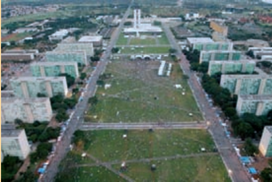
Vue de l'espace central de Brasília (image en libre accès sur internet)
