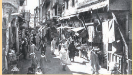
Vue du Mellah - Casablanca
