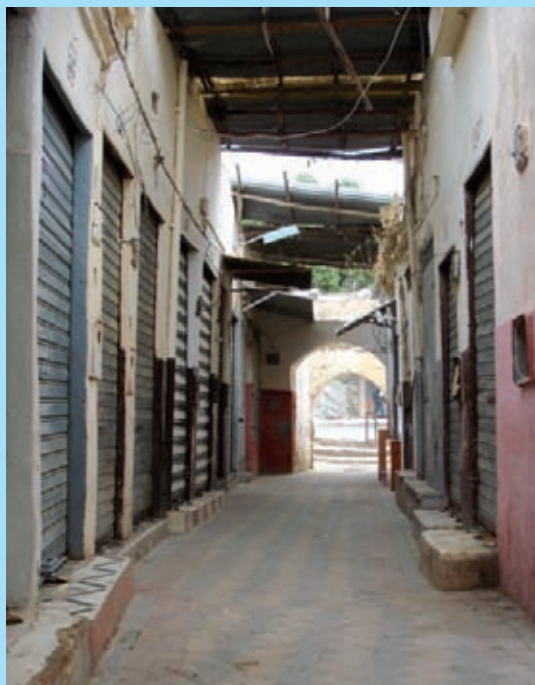
Souk Attarine à Ksar Lkbir. État avant ...
